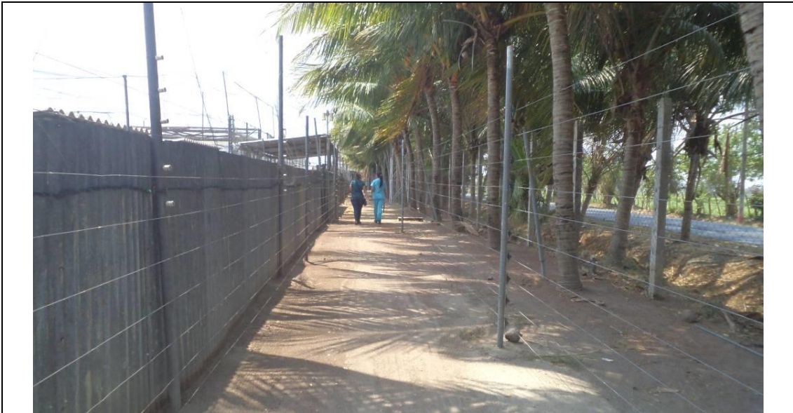
Fotografía 2.8. Medidas de seguridad: cercas de malla ciclón, lámina galvanizada y cercas electrificadas.
